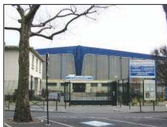
La Halle Georges Carpentier entre Porte de Choisy et Porte d'Ivry
